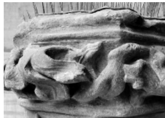
Konsole am Nordportal West nach der Restaurierung
