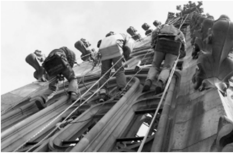
Fugensanierung am Turmhelm.
